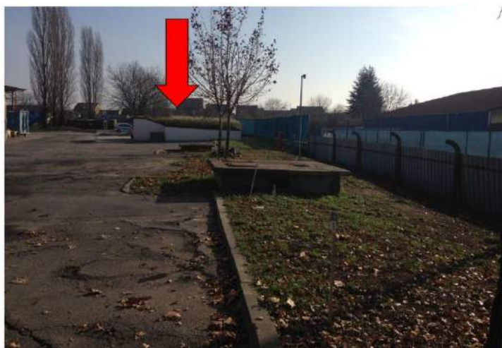
Slika 2. Lokacija planiranog uređaja za pročišćavanje tehnoloških otpadnih voda
