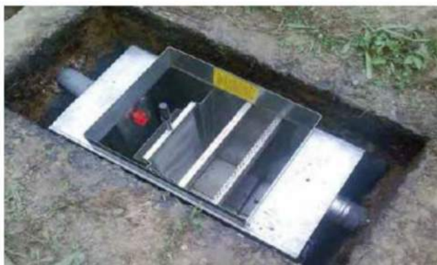
Slika 3. Prikaz ugradnje mastolova
